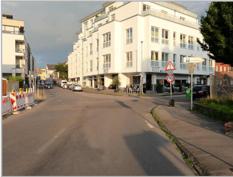
Abb. 44: Kreuzung mit der Lehnstraße: unnötig große Sperrfläche, unsichtbarer Radverkehr von rechts
