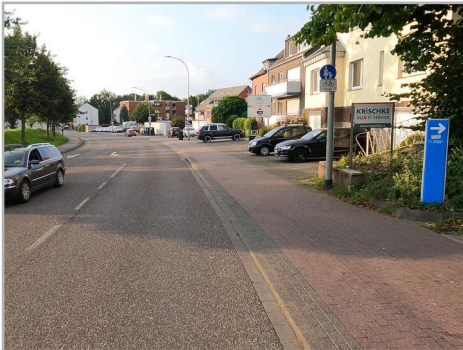
Abb. 32: Ende für Radfahrende: keine Führung auf die Fahrbahn
