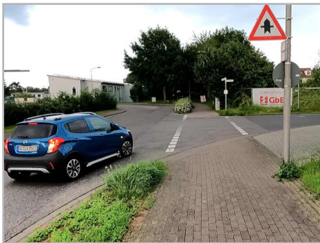
Abb. 47: Kreuzung zur Kesselsgracht: fehlende Sicht auf den Radverkehr, kombiniert mit schlechter Markierung
