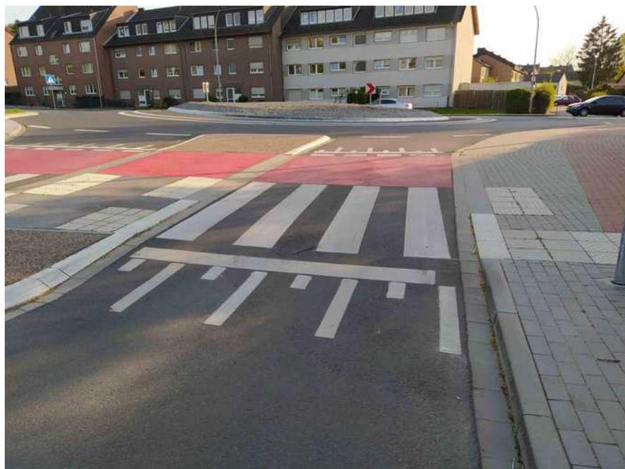
1.2: Die Radwegefurt wurde sowohl auf der Fahrbahn wie auch bei den Radwegen in rot ausgeführt, jedoch nicht komplett für den umlaufenden Radweg. Wieso ist der Fahrradbereich nicht glatt durchasphaltiert und insbesondere durchgängig eingefärbt?
