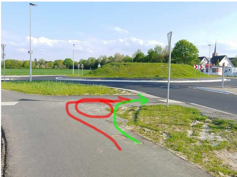
7.2 Die Führung auf die Fahrbahn ist eine echte Nullabsenkung: so sollten alle Übergänge sein. Allerdings birgt die Verschwenkung des Bordsteins und der gestrichelten Linie die Gefahr eine Kollision mit einem von hinten kommenden PKW. Hier wäre es besser, diese Verschwenkung zu entfernen und statt der gestrichelten eine durchgezogene Linie aufzubringen.
