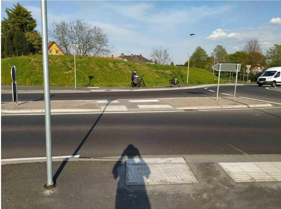
5.3 Die Zufahrt auf den linksseitigen Radweg in Richtung Kreisverkehr / Pley ist sehr ungünstig gelöst. Zum Einen ist die Kurvenführung nur etwas für geübte Radfahrer. Andererseits ist schwer erkennbar, dass das linksseitig aufgestellte Schild Kombiniertes Rad-/Fußweg für die Weiterfahrt gerade aus gilt (roter Pfeil und Kreis). Günstiger wäre hier eine spätere Führung auf die linke Seite.
